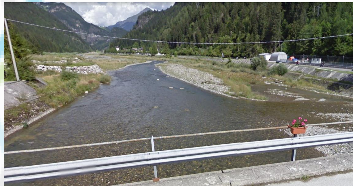
Area torrente Cordevole a monte del ponte di S. Maria ed estensione a nord del Lago di Alleghe
